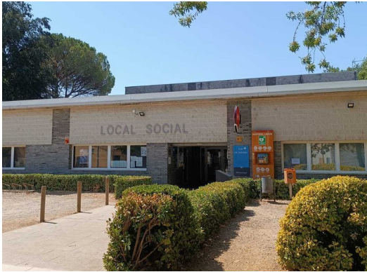
Exterior del local social de Quart AJUNTAMENT DE QUART.
