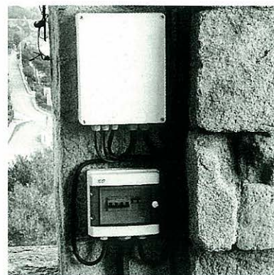
Seqüència dels aparells de control instal·lats al campanar de Castell d'Aro: control horari remot, caixes de distribució i electromartell.
