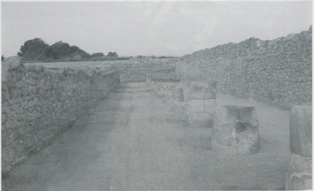
Imatge del criptopòrtic del fòrum després de la intervenció efectuada per recuperar els nivells de circulació antics.
