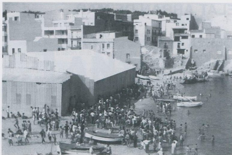
A la foto veiem l'envelat quasi a tocar la llonçada. El públic que s'hi veu presenciava les proves de natació de la festa major d'aquell 1979.
