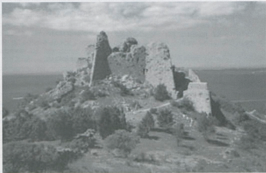
El Castell de la Trinitat abans de la seva rehabilitació, iniciada l'any 2002.
