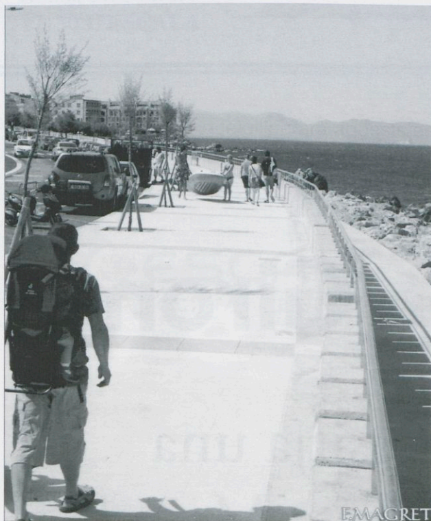
Nou aspecte del Passeig del Mar, un cop reparats els desperfectes causats pel temporal de finals de l'any 2008.
