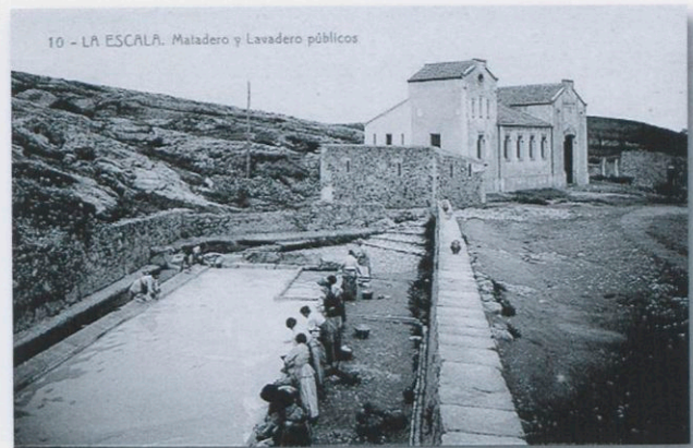
L'antic escorxador de l'Escala (actual seu del MASLE), situat fora vila, va ser inaugurat a les acaballes d'aquell 1913 (foto: J. Alech; cedida per Rafel Bruguera)
