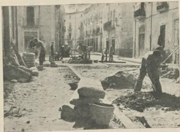
Obras de pavimentación de una de las calles de la Villa
