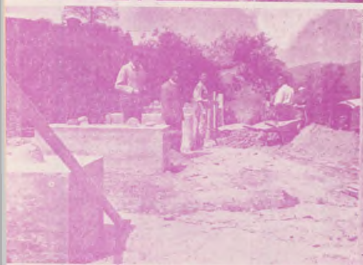
Cimentación y pilares en el acueducto de «can Pol»
