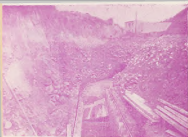
Excavación en el canal principal
