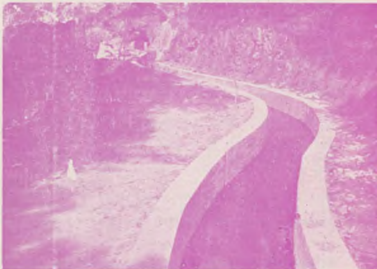
Canal principal y entrada túnel n.º 2.
