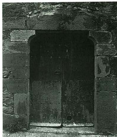
Portal de can Gironès, del veïnat de Sobràrigues.
