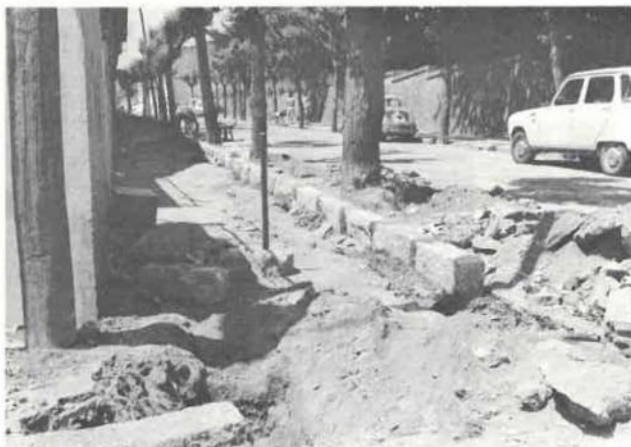
Noves voreres en el carrer Sant Josep
