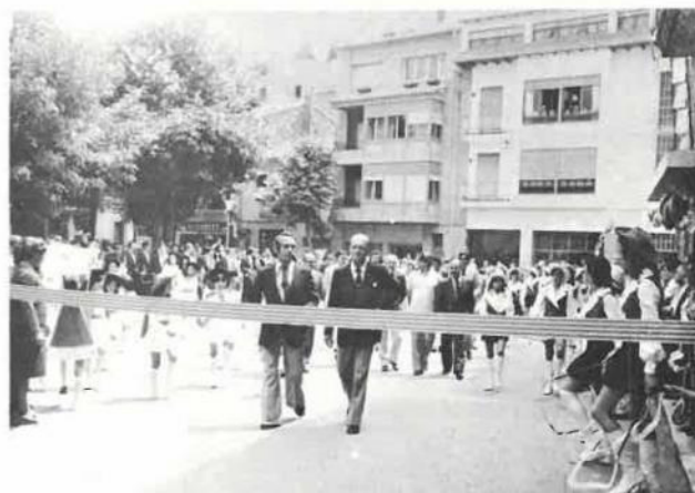
Inauguració de l'asfaltat dels carrers per part de l'Excm. Governador Civil
