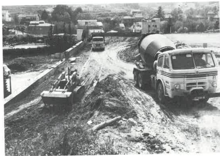
Obres del camp de futbol.
