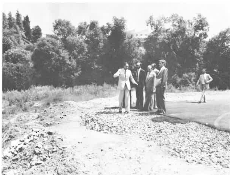
Visita a les obres d'asfaltat del poliesportiu.
