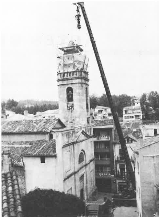
Col·locació de la part del ferro que culmina el Campanar.
