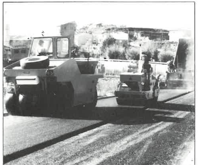
Asfaltament de nous carrers
