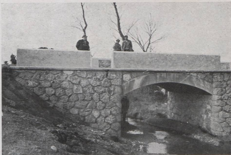
Pont sobre la riera de Tongà en el camí de Garrigàs a l'estació de Vilamalla, per Tongà
