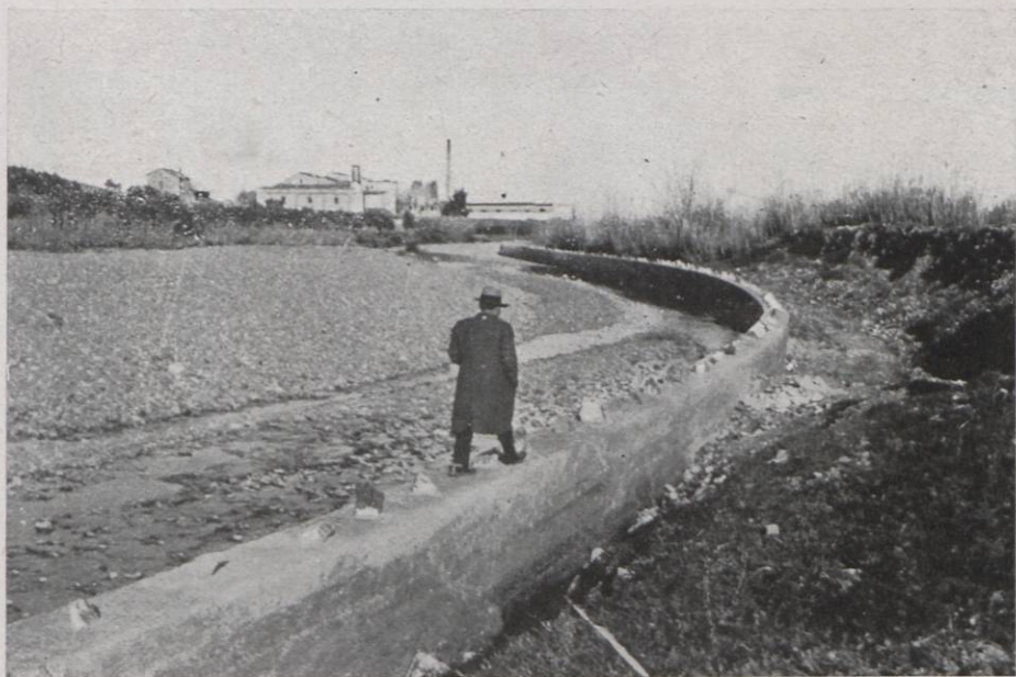
Mur de defensa de Llançà
