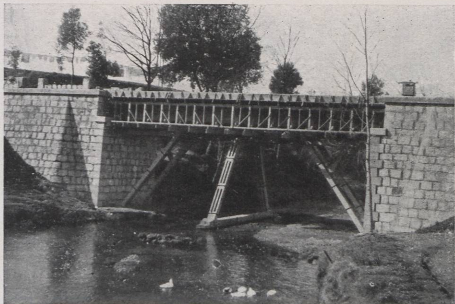
Pont en construcció sobre el Terri en el camí de Pujals dels Cavallers
