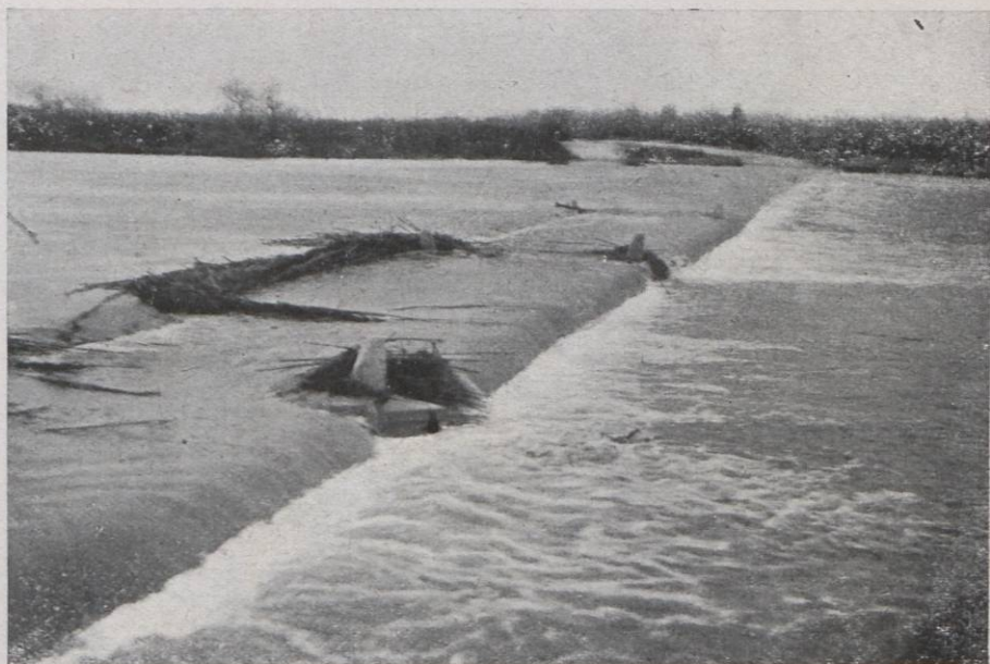
Pont «badén» sobre la Muga, en el camí de Figueres a Sant Climent, cobert per les riudes
