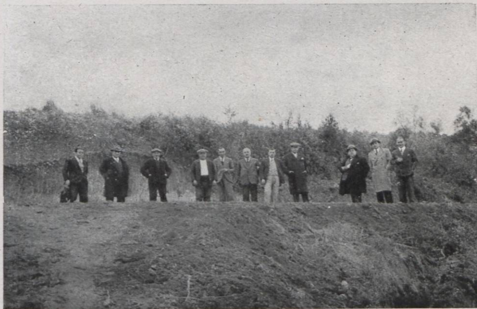
Camí en construcció de Foixà a Rupjà
