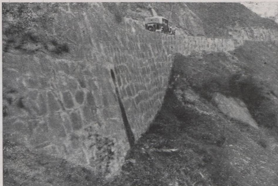
Mur de sosteniment en el camí de Pujarnol a Banyoles
