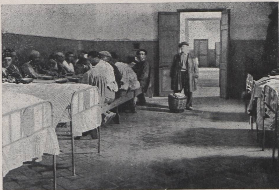
Sanatori Martí i Julià. – Aspecte d'un dormitori de l'antic pavelló d'homes
