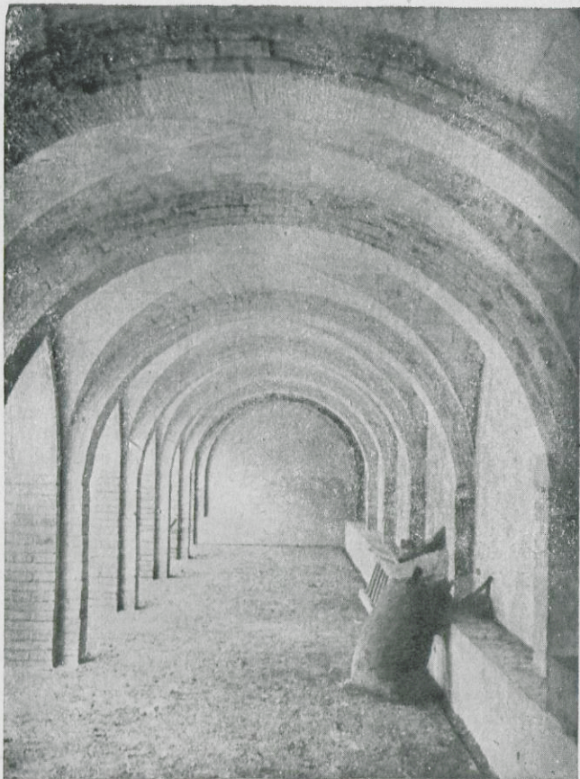
Casa de Vells d'Agullana. — Galeria exterior per a sosteniment de terres que s'utilitza per a diferents serveis
