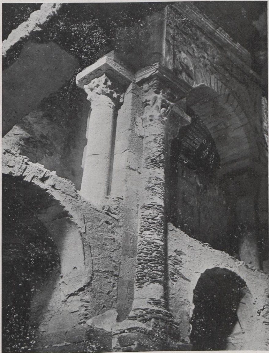
Monestir de Sant Pere de Roda, abans de les obres de consolidació
