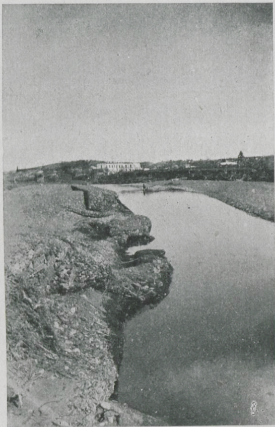
Mur de defensa a La Bisbal, després de l'avinguda del Daró en 1933
