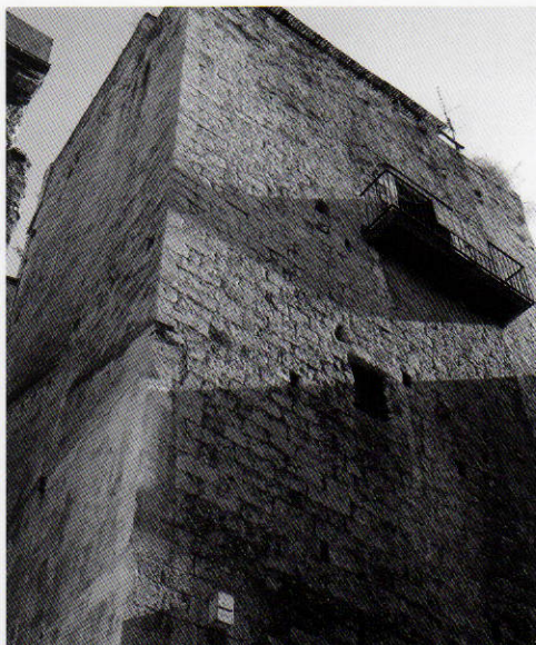
Les muralles reforçades van aguantar les investides dels atacants, que no pogueren traspasar-les.
