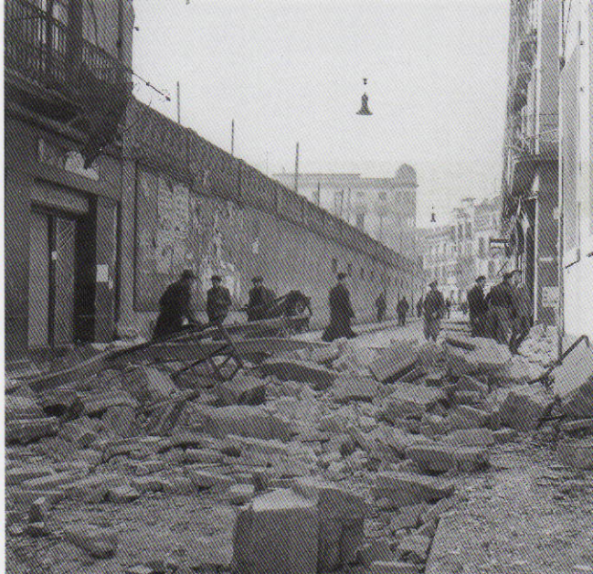
Malgrat les mesures adoptades per la Defensa Passiva, els efectes dels bombardeigs al centre de la ciutat són ben evidents amb aquesta imatge de les destrosses que va haver-hi al carrer Nou després d'un atac mortífer dels avions enemics.
