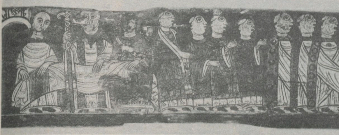
Detalle de la viga de Cruïlles.
