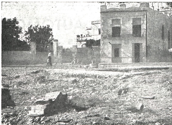
Estado en que quedó la Plaza de la Fuente recién asfaltada.
