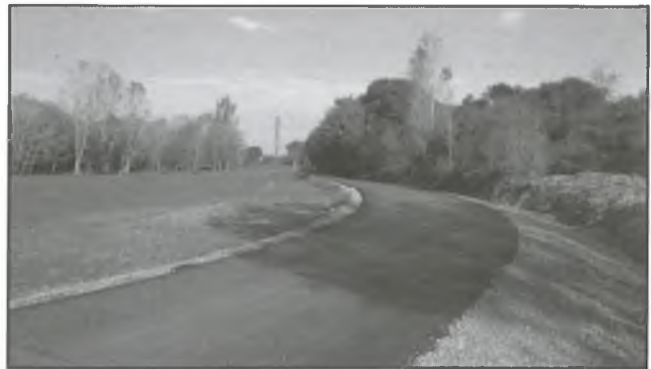
Imatge de l'asfaltat del camí de Can Solà I
