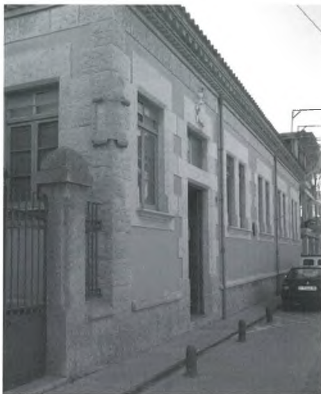
Façana de l'edifici que allotja la biblioteca
