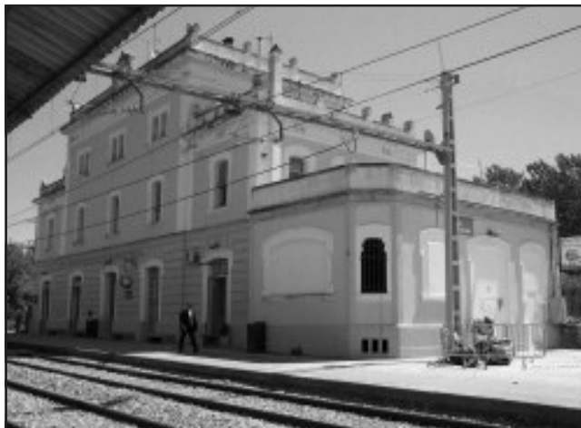
Vista de l'estació
