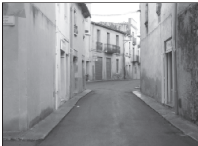
Tram superior del carrer Major acabat d'asfaltar
