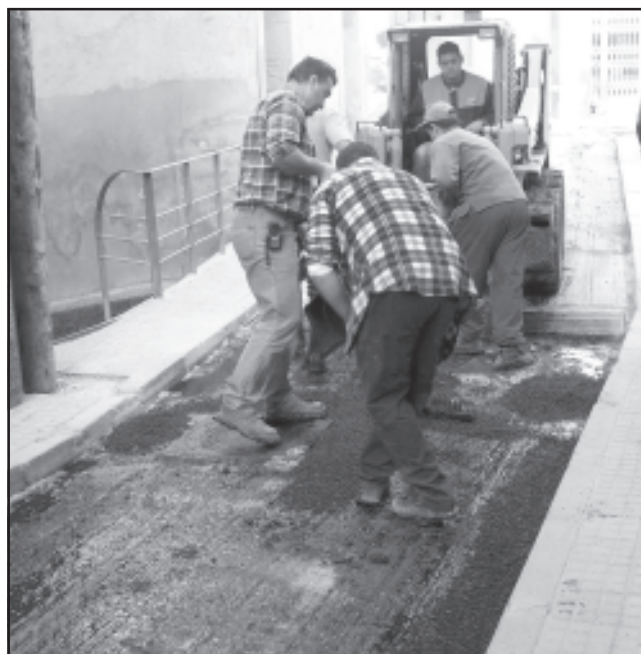
Les feines d'asfaltatge
