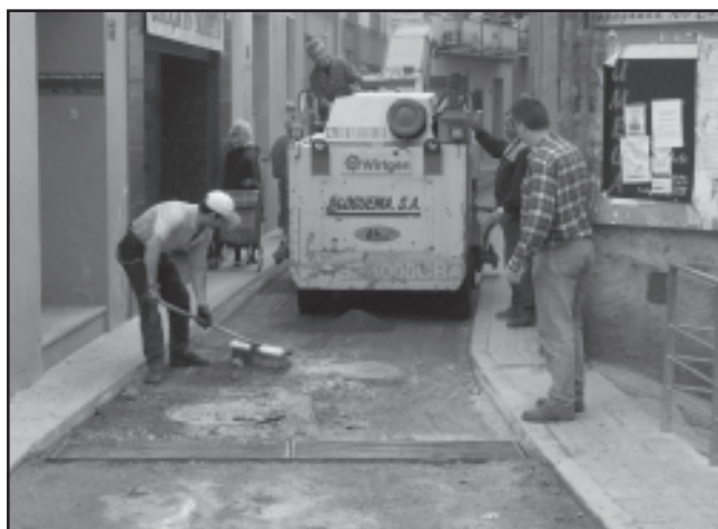
Abans es va haver de treure l'asfalt vell
