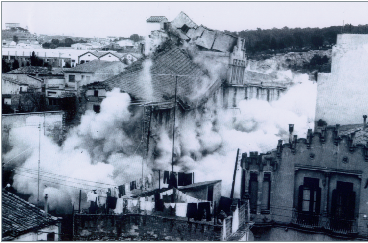
Imatge de l'enderrocament del Balneari Soler
