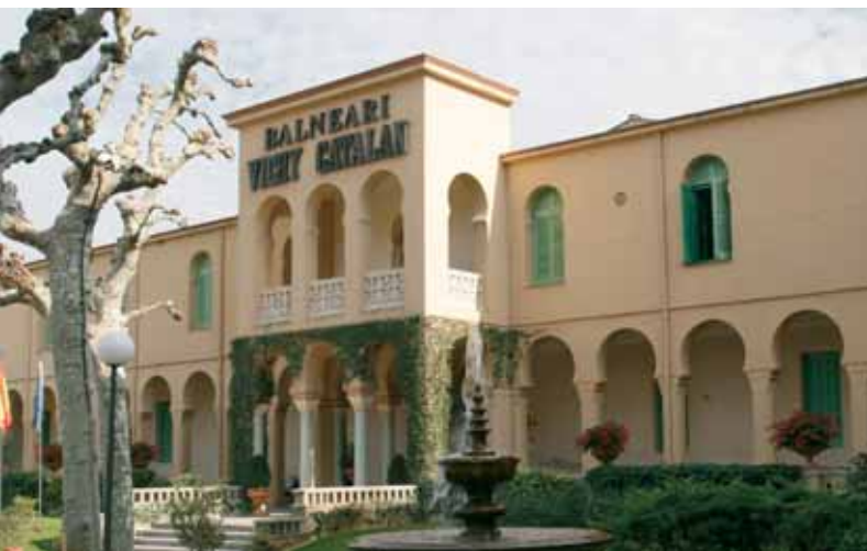
Façana del Balneari Vichy Catalán
