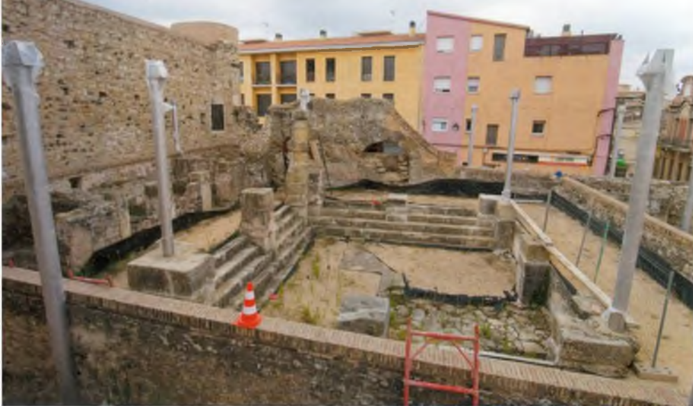
Les obres de col·locació de la coberta
