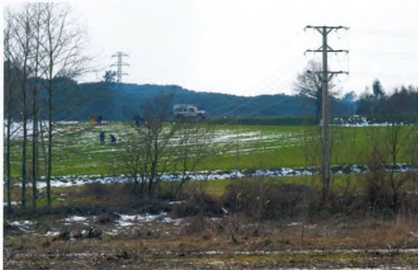
Tècnics reparant una línia caiguda.
