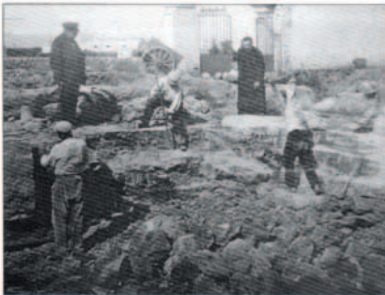
Vista parcial de les tasques d'excavació de les termes feta per Norbert Font. La important capa de sediment calcari que s'havia dipositat sobre les restes obligà a excavar el conjunt territorial a barrinades i cops de mal.
