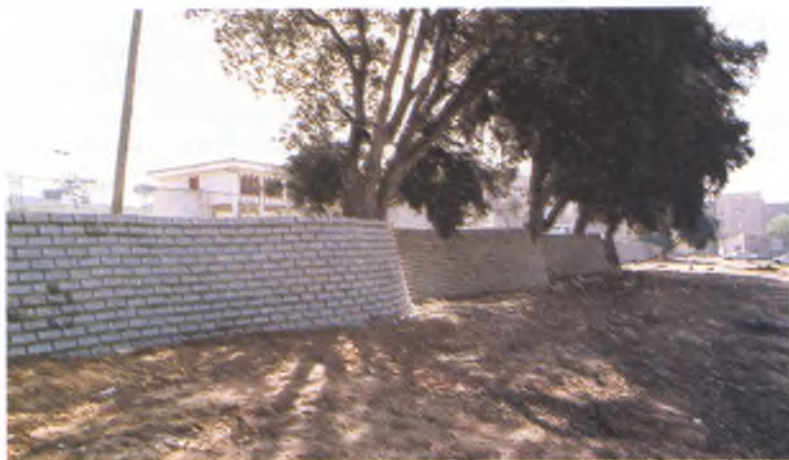
◆ Construcció de mur de contenció de terres al carrer Corunya. Contractista Construccions Luque. Pressupost 3.551.216 Pta
