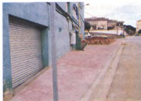
◆ Construcció de vorera i parterre al carrer Bilbao. Brigada d'Obres Municipal.
