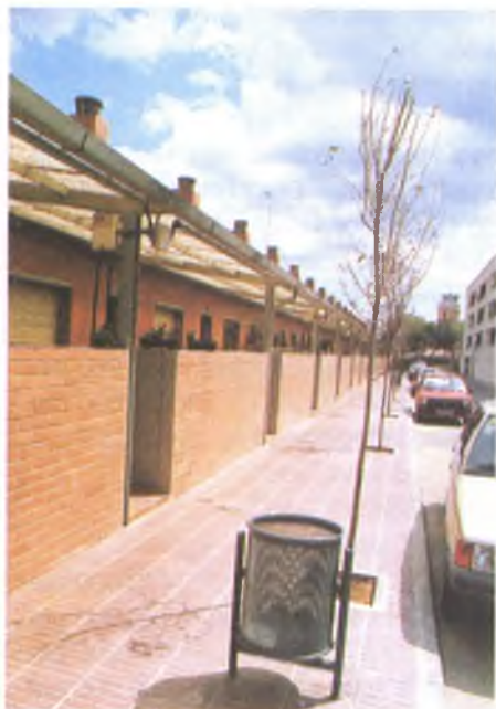
◆ Plantació d'arbres, construcció d'escossells i col·locació de papereres al carrer Bartrina. Instal·ladors: Aviñó: plantació d'arbres, Brigada Municipal d'Obres: construcció d'escossells i la col·locació de les papereres.
