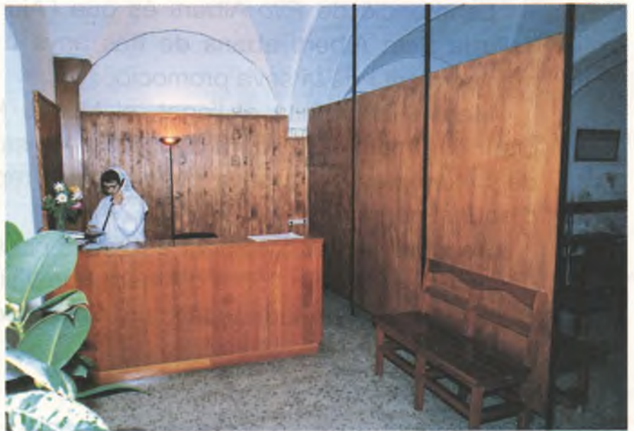
◆ Obra: Construcció de recepció a l'Hospital Municipal. Alumnes de Pretallers.
