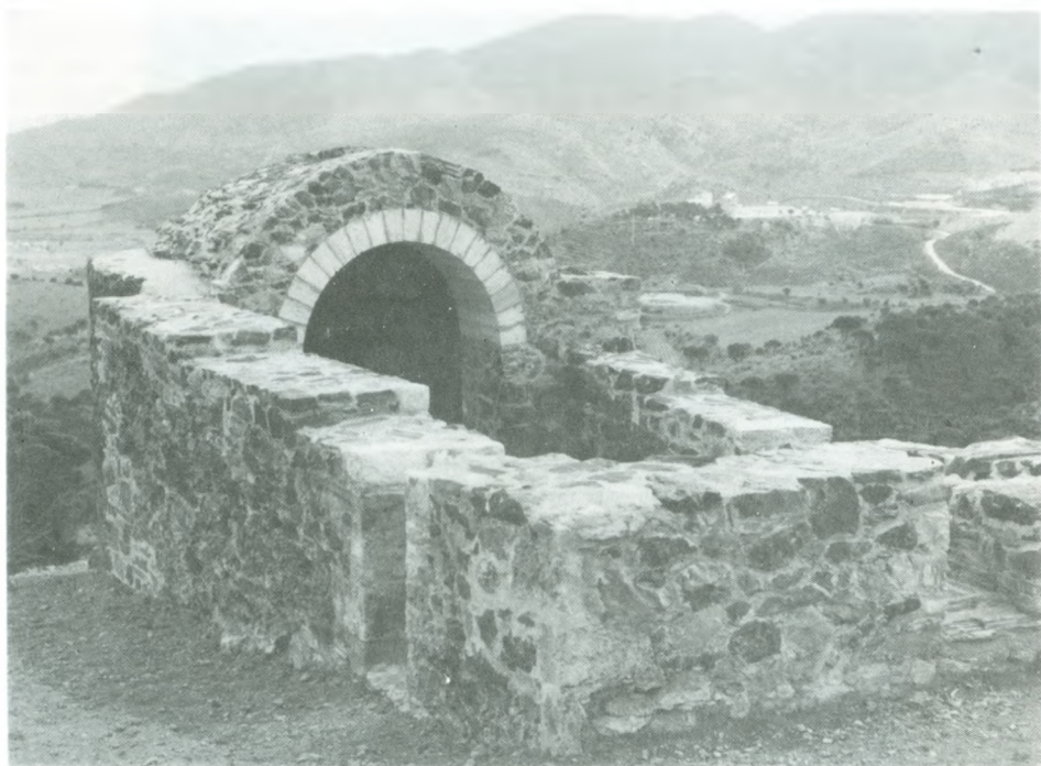
Aspecte actual de l'ermita, després de les obres.
