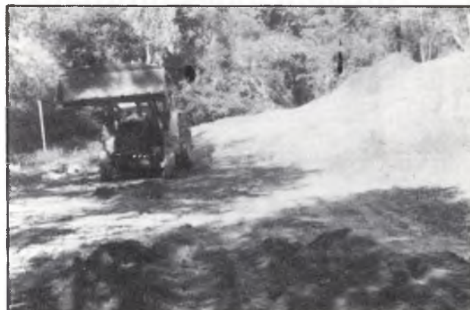
Construcción Mini-Pista Polideportiva en Palol d'Onyar.
