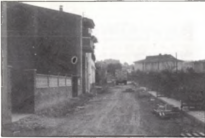
Urbanización Calle Almeda
