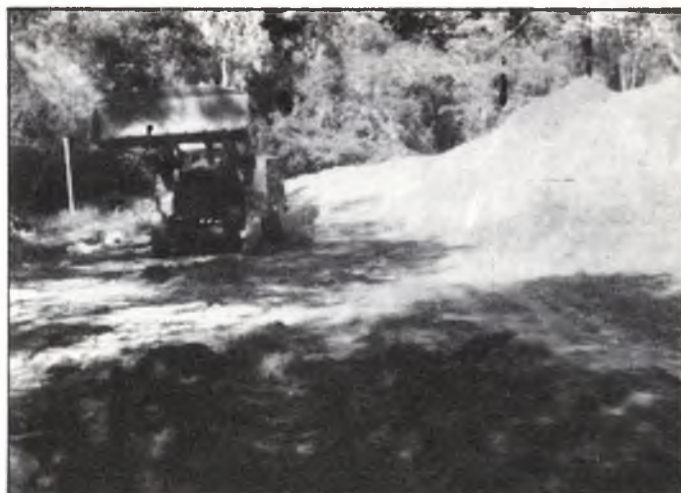
Construcció Mini-Pista Poliesportiva a Palol d'Onyar
