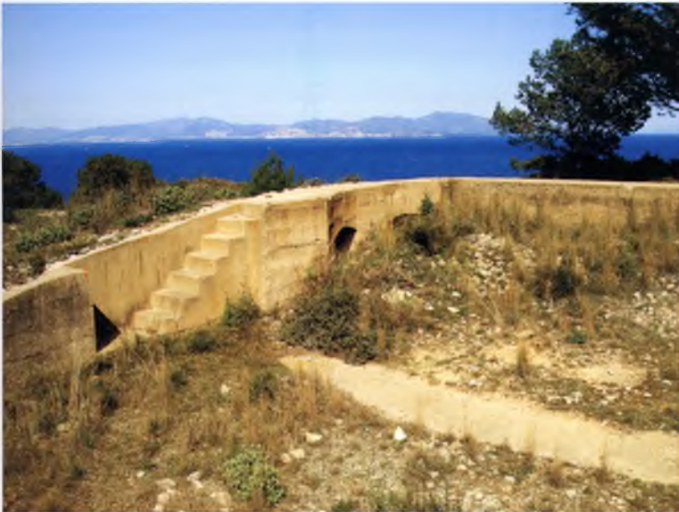
Restes de la bateria de canons que s'instal·là a la zona de les Planasses. Arxiu Rafel Bruguera.
