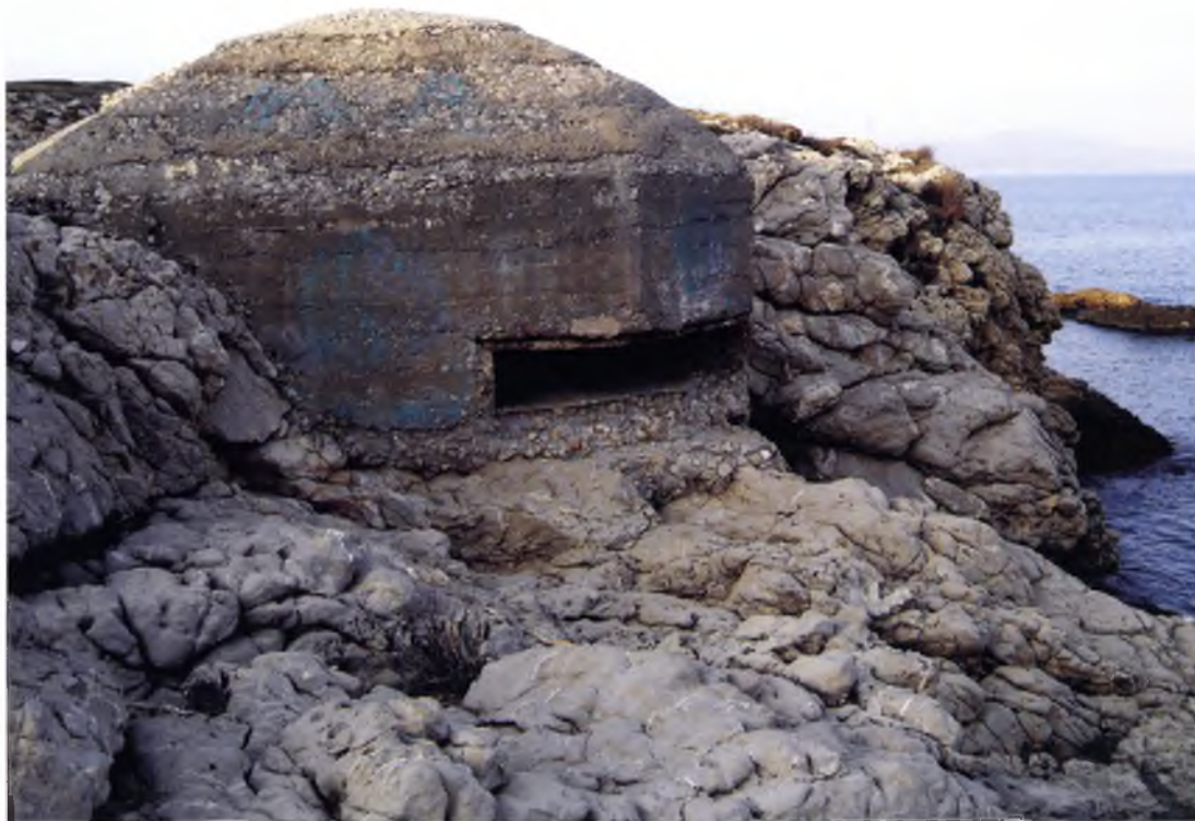
Búnquer de les Coves, construït pels milicians de la costa. Autor: Joaquim Teixidor.
