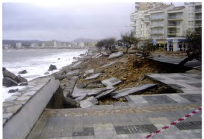
Esfondrament del Passeig de Mar a l'Escala, arran de la llevantada del 26-12-2008. / Foto: Quim Teixidor.
