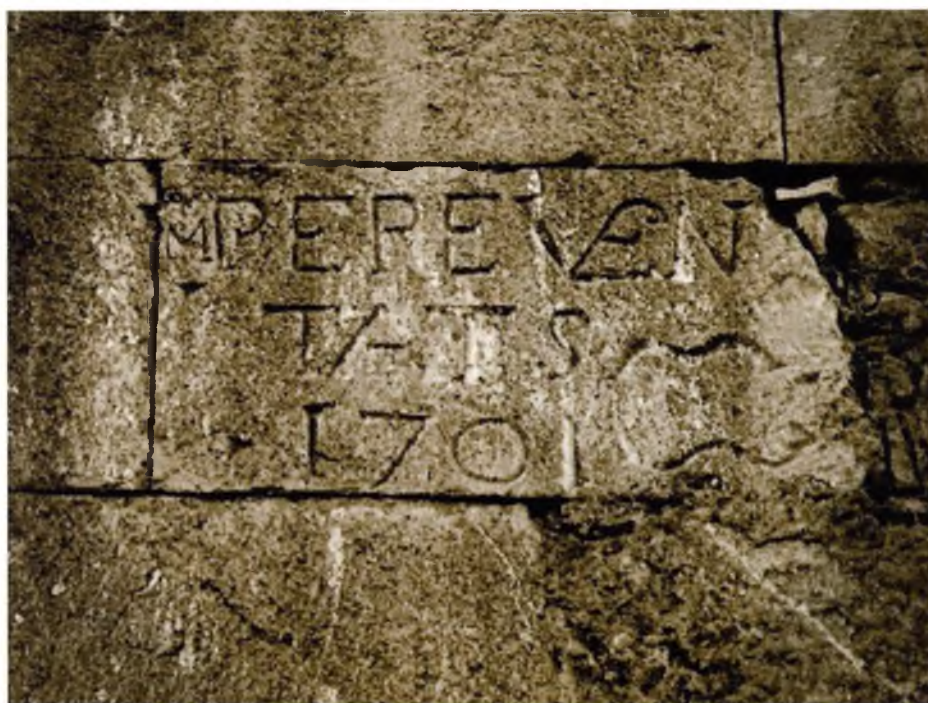
Bloc de pedra en record de l'inici de les obres amb la inscripció 'M. Pere Ventats. 1701'. La inscripció inclou el segell del mestre d'obres. / Foto: Quim Teixidor.
