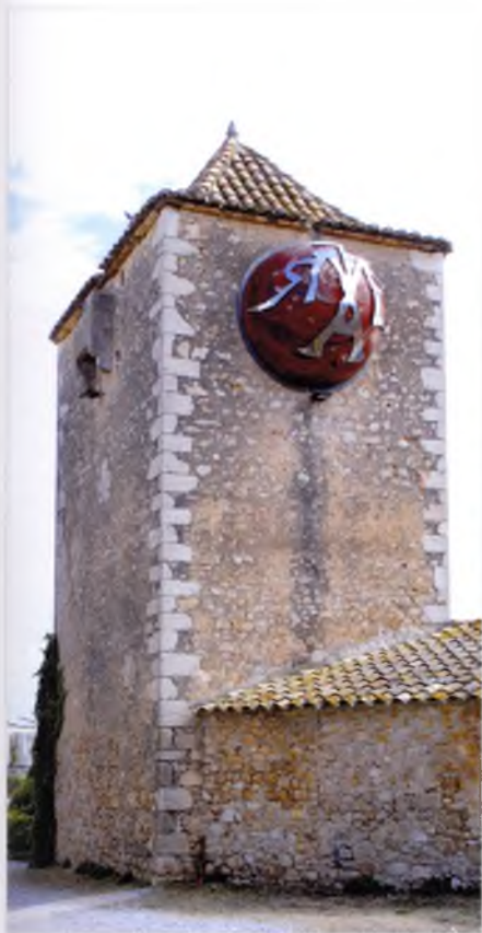
La torre del mas Vicenç dels Recs, de planta quadrada i teulada a quatre vessants.
