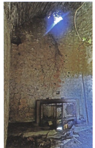
Interior de la barraca del pla de les Corts, de volta de canó, amb l'encanyissat. A baix l'antiga comporta de ferro. Foto: Lurdes Boix.
