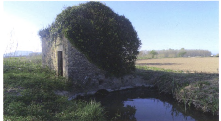
La barraca del pla de les Corts, per distribuir l'aigua del rec del Molí cap a la riera de les Corts. Foto: Lurdes Boix.
