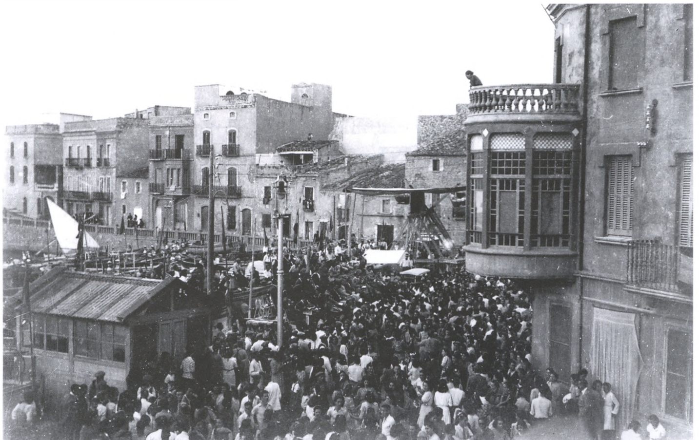
Festa major de 1935. La caseta ja protegeix la instal·lació. Foto: Joaquim Palau, arxiu Ramir Palau.
