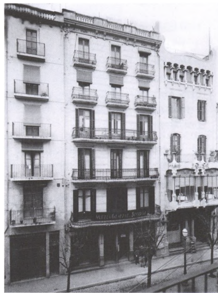
Imatge de l'edifici a la Rambla de Girona que albergava en la seva primera planta les oficines de la Mutua General de Seguros. Fons: CRDI (Ajuntament de Girona).
