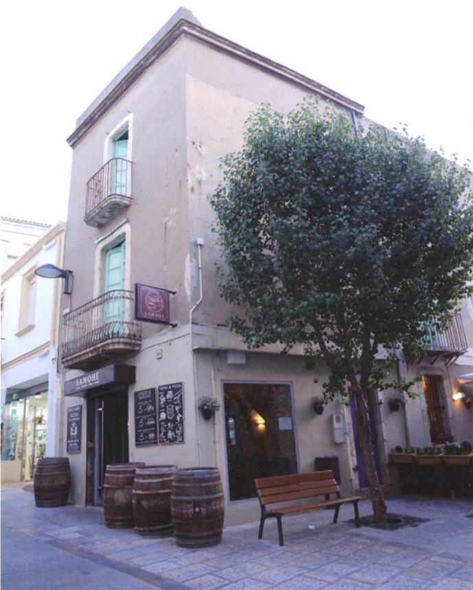
Aspecte actual del immoble del número 40 del carrer del Port en el que hi hagué la farmàcia Guillot, que feia cantonada amb el Pati Blau, carreró adjacent i de sortida de la farmàcia.
