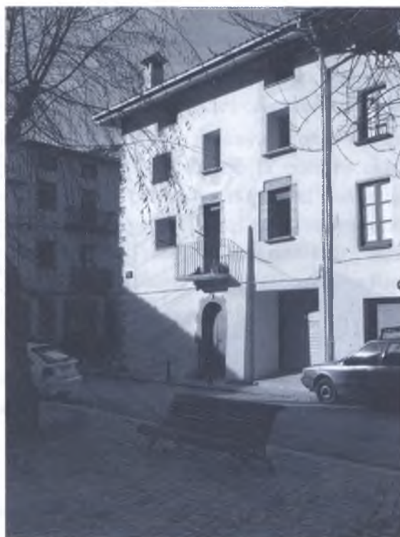
A les fotografies de la dreta, disposades en columna, veiem l'aspecte que ofereix la mateixa casa abans (fotografia superior) i després (fotografia inferior) de ser pintada. És la primera remodelació portada a terme amb l'ajut de la bastida municipal.
