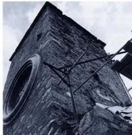
Obres de remodelació a la torre del rellotge.
