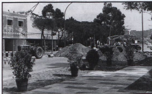
Obres de construcció de les galeries St. Lluís.
