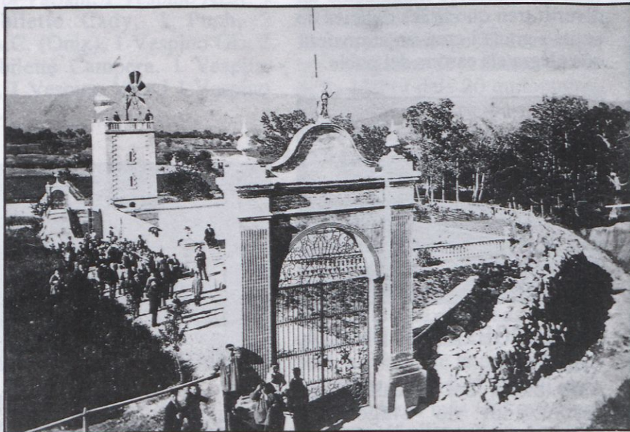
L'entrada de Can Vicens després d'unes obres de reforma.
