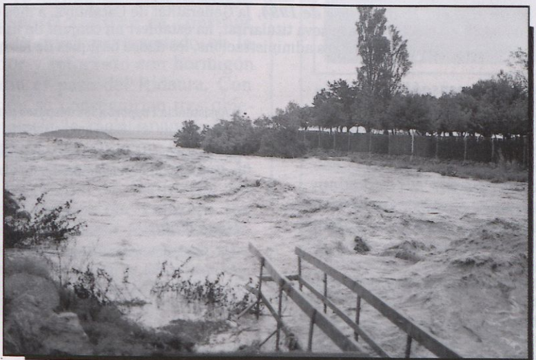
■ L'últim tram del Ridaura quan desguassa al mar. La força de les aigües s'emportà el pont que hi ha a l'altura del Shopping Center Ridaura.
