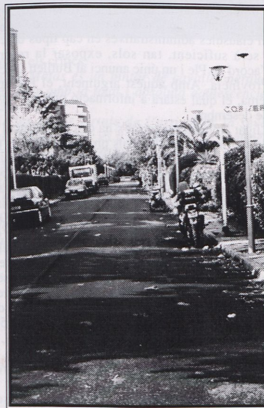
La urbanització Aro Gran amb les obres ja fetes.
