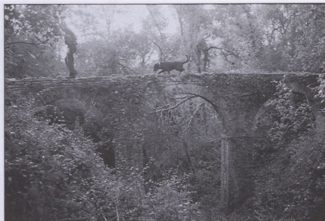
L'aqüeducte de la canalització de Can Vilallonga
