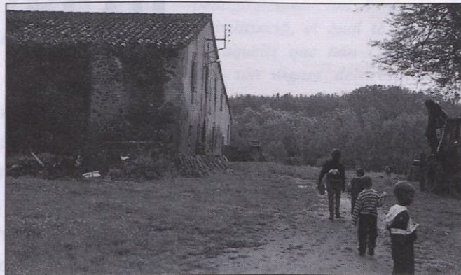
Can Vilallonga el dia de la Marxa de Primavera poc abans de començar les obres de restauració.
