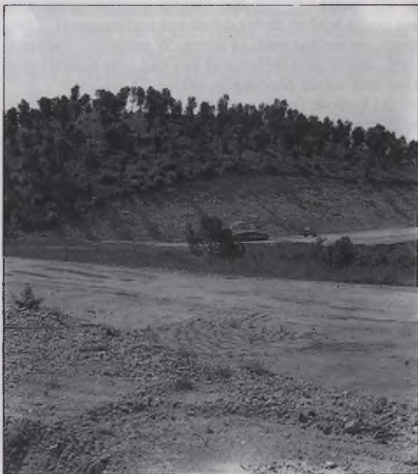
Construcció Golf Mas Nou
