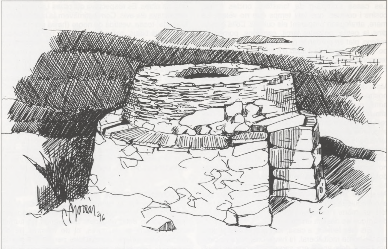
Barraca circular del Ximblar. Cal destacar-ne les considerables dimensions, les dues finestres a llevant i ponent i, sobretot, l'acurada execució. Malauradament, les lloses que clouen la volta han caigut, fet que provocarà l'enderroc de tan valuosa construcció.
