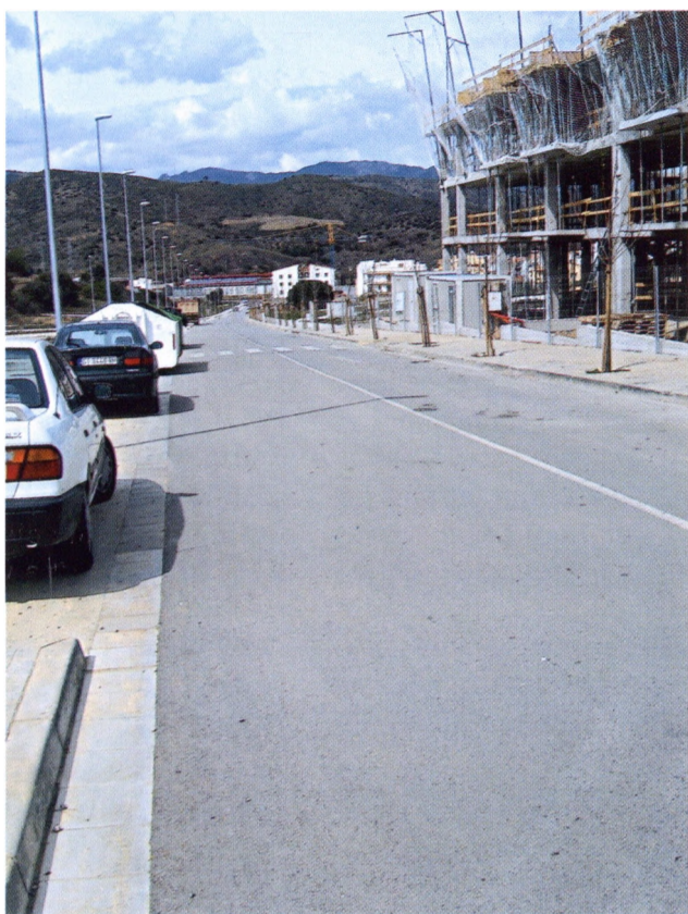
El carrer Antoni Margarits, a la nova urbanització municipal.
