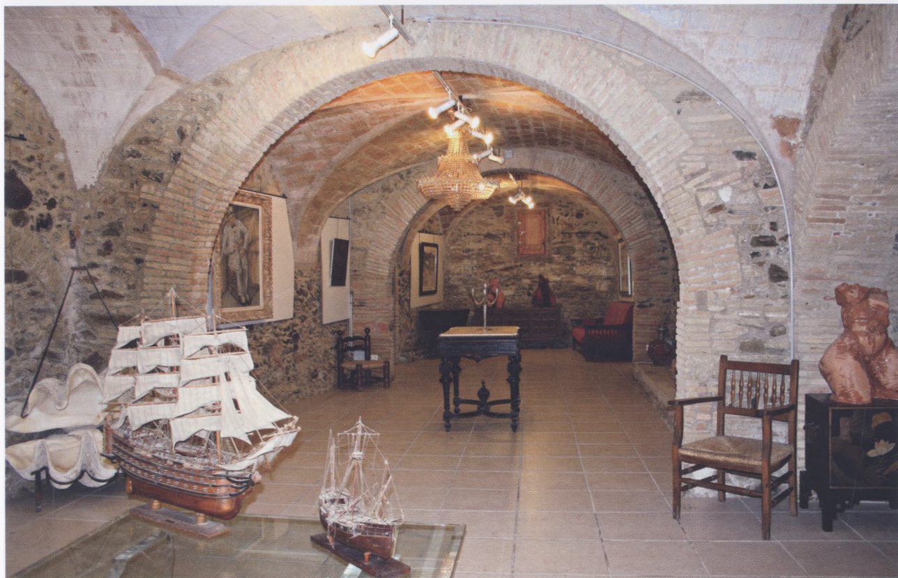
Baixos de l'antiga casa dels Cremadells, on els Ferrer i Batlle tenien el celler i la cort. Un tipus de construcció que recorda la volta catalana, feta de maons, rajoles i pedra del país, rehabilitada pel tercer propietari, Martínez Lozano.
