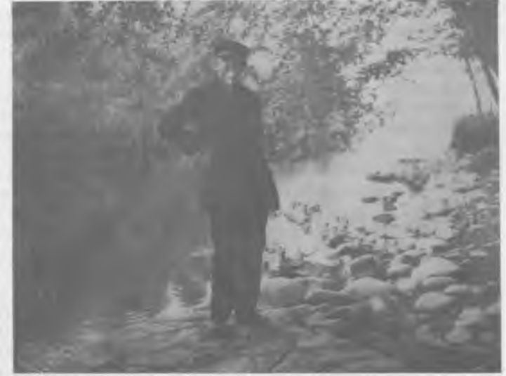
L'EVARISTO en el lloc on precisament començava la travessia. Encara a terra queden restes del cable.
