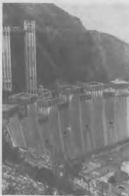
No hagués valgut més que al febrer de 1967, que fou quan vaig fer aquesta fotografia, s'haguessin parat definitivament les obres?
