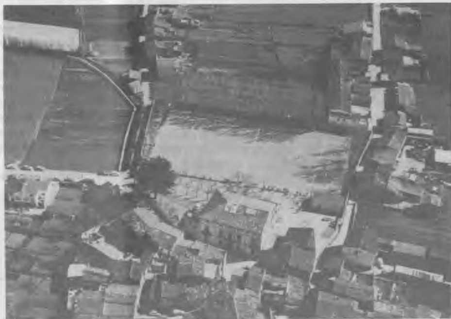
Una bonica vista de l'actual camp d'esports, que tots desitgem que ben aviat canviï d'emplaçament. Llavors, tan sols serà un record aquesta fotografia aèria. Hem de felicitar a l'encarregat de marcar el camp per les seves línies tan rectes.
